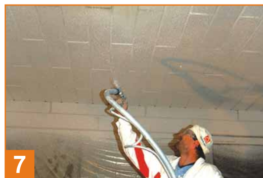
Nanoszenie warstwy wierzchniej - tynku IKK / KHK.
