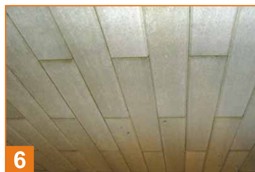
Powierzchnia gotowa do naniesienia warstwy tynku IKK / KHK.
